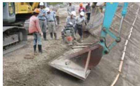
セメントスタビライズした 2B 層の施工
