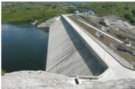
湛水試験中のポンレポンレダム (09年6月撮影)
