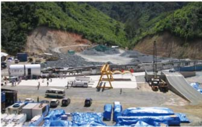
TBM 組み立て
