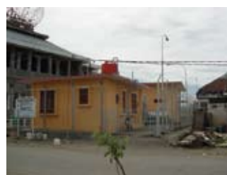
排水ポンプ場
