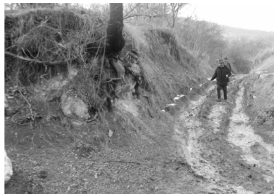
雪解け時に活性化するゴッシュユ村の地すべりと泥濘化しているコミュニティ道路
