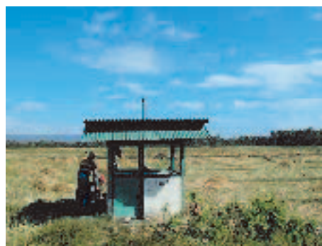
オエサオ地区地下水灌漑施設
