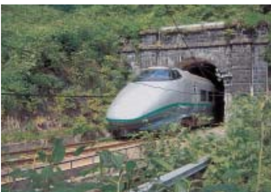
写真-9 センサ設置想定地点(奥羽本線)
