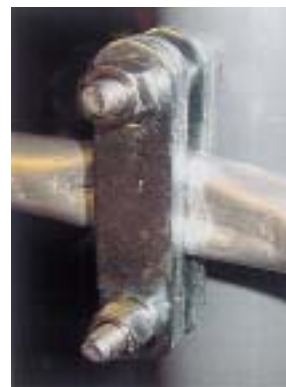
写真-3 アルミ管固定金物
