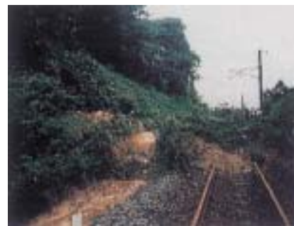
写真-1 切取崩壊による建築限界内への土砂流入
