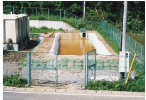
写真-5 ろ過池の近景
