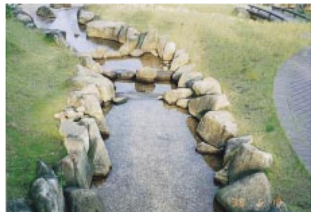
写真 - 7 除鉄後のせせらぎ放水状況
