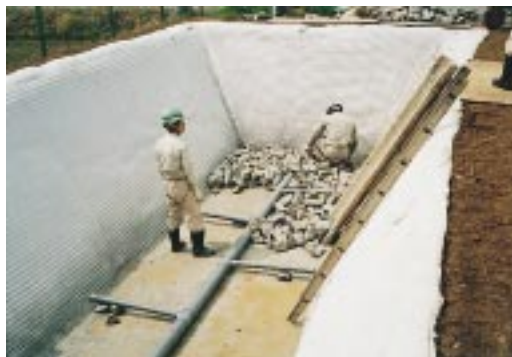
写真 - 6 集水管と防護用玉石の敷設
