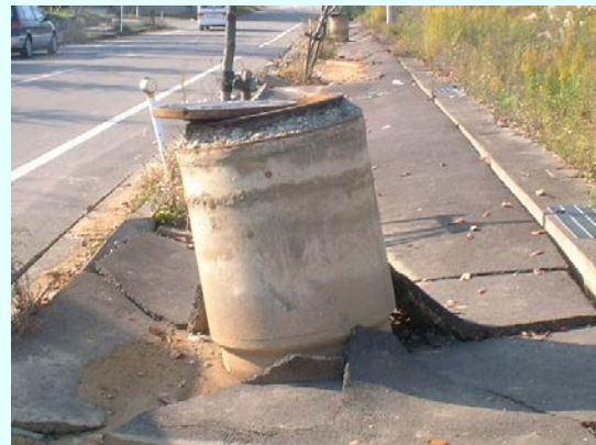
写真-1 液状化によるマンホールの浮上現象（新潟中越地震）
