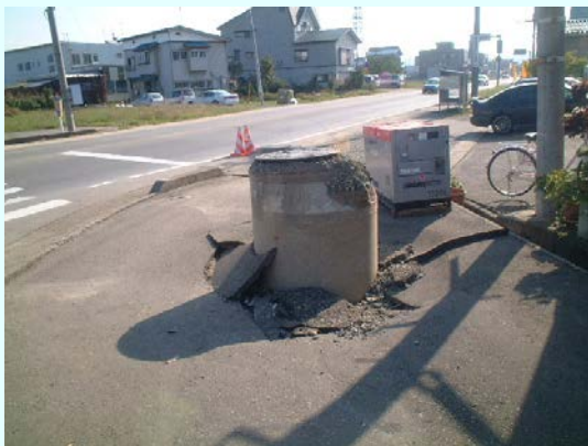
写真-1 液状化によるマンホールの浮上現象（新潟中越地震）
