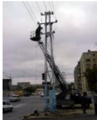
配電線補修工事の様子
