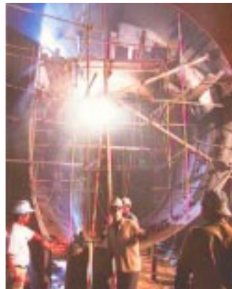
地下鉄管工事
