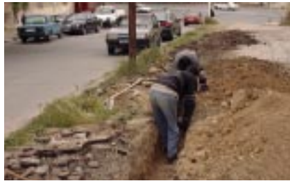
地中線ケーブル用掘削工事の様子
