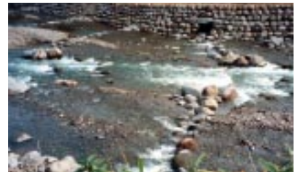
事例 『鳥居川水辺環境の保全・創出』洪水対策の砂防工事において、生態系の復元と生物の多様性を確保する近自然型工法を提案しました。
