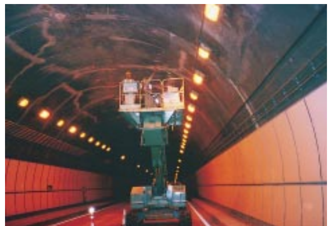
写真 - 1 非破壊試験による調査状況（道路トンネル）
