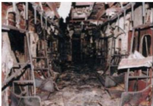
図-2 Degue Metro の被害状況
