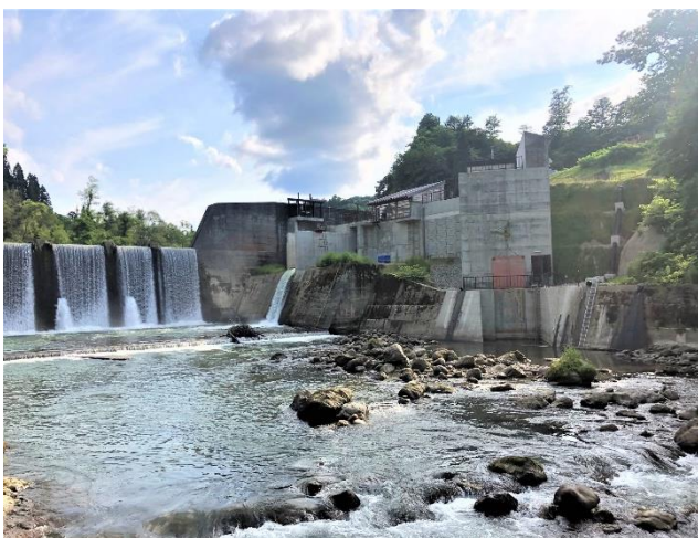
写真-1 おおくら升玉水力発電所
