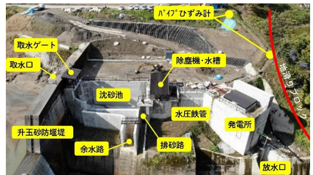
写真-3 発電所全景(建設中)
