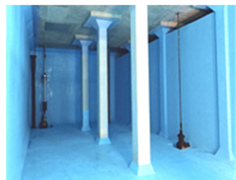
写真-11 上水道用配水池の施工例
