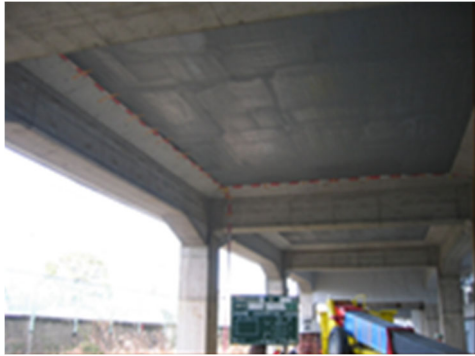
写真-12 高架橋の施工例
