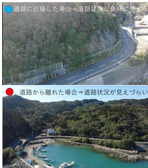
図-10 道路への近接程度の違いによる視認性 (上: 高度 30m、水平離隔 30m、 下: 高度 50m、水平離隔 200m)
