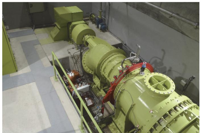
写真－2 発電所内部（S型チューブラ水車、誘導発電機）
