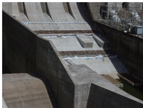
写真-8 スロットジョイントの養生状況
