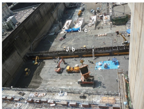
写真－2 RCD 施工状況（平成 29 年 4 月 12 日現在）
