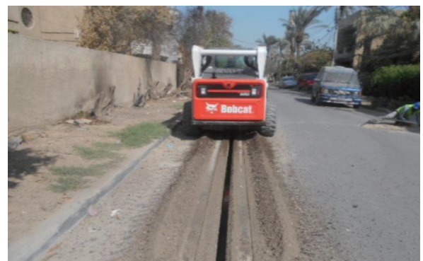
写真－1 当該工事で使用したミニトレンチ切削機
