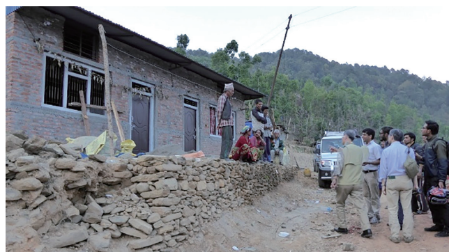
写真-5 2015年ネパール地震被災地調査 22) (Irkhu Village, Sindhupalchowk District)
