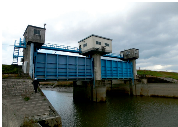
写真－1 江見手水門（本川側より見る）
