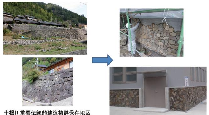
写真-3 発電所腰壁の石張り状況
