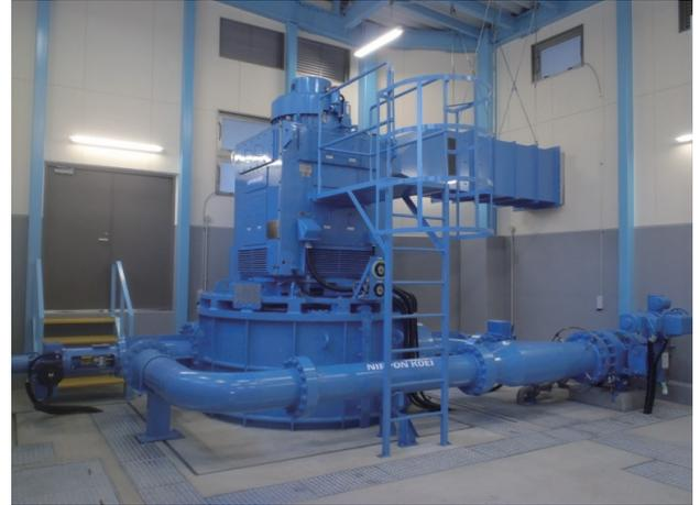
写真-2 立軸ペルトン水車・発電機（更新後）
