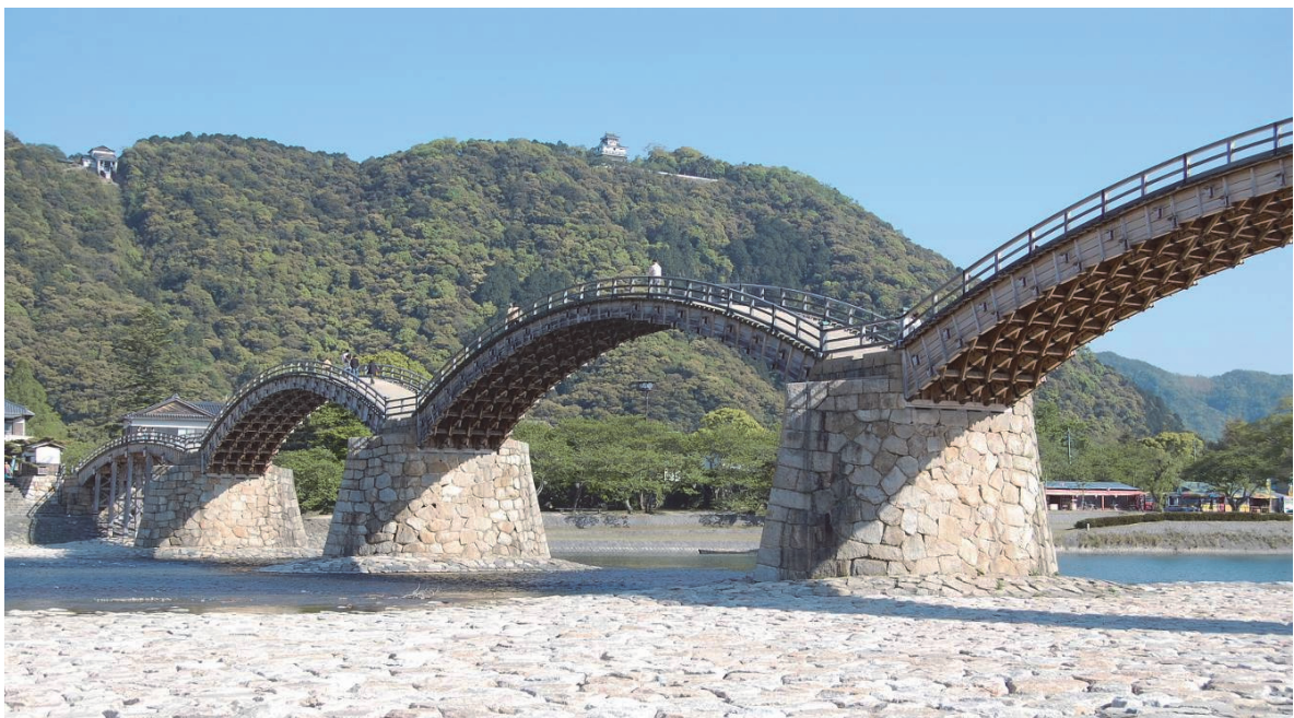
写真-1 錦帯橋下流側前景（錦見側より見る）
