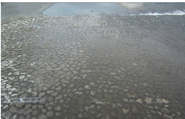
写真－2 河床の石張り
