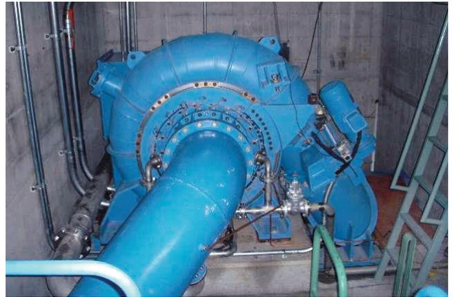
写真-2 寺山ダム発電所のフランシス水車(最大出力 190kW)
