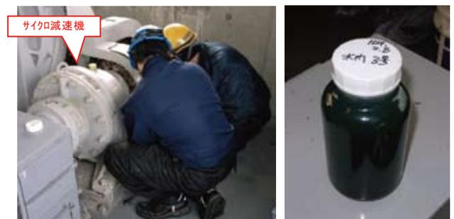
写真-2 江戸川水門サイクロ減速機潤滑油採取状況 (右は採取された潤滑油)
