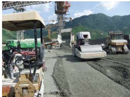
RCCダム施工
