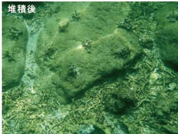
写真－7 漂砂による沖側基盤石の堆積
