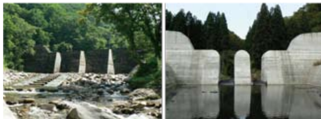
(既設砂防えん堤のスリット化) (スリット式砂防えん堤)
