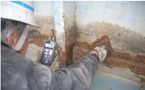
写真－1 S 樋門板厚測定状況
