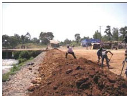
写真-3 ニヤマサリア川の護岸工事 (オデン村)
