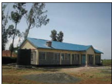
写真-4 完成した避難所(コクワロ村)
