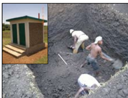
写真-5 トイレの掘削および完成したトイレ (コクワロ村)
