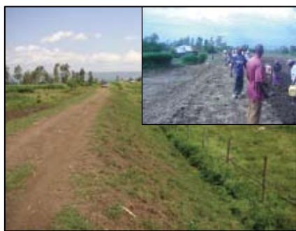
写真-7 ニヤンド川堤防の改修・補強 (コチエオ村)
