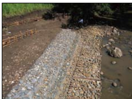
写真-6 完成したバラゲット川の護岸工 (カミワ村)
