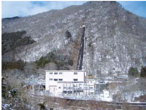
栗山発電所全景
