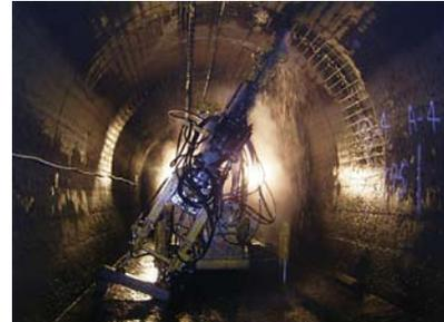
写真-8 ラドスによる注入孔削孔状況
