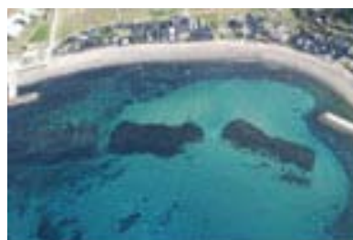
海中構造物の損害状況
