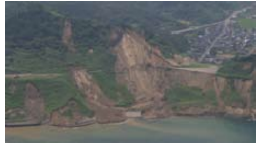
図－12 海岸部の斜面崩壊および濁水発生状況
