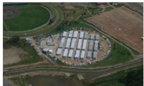
図－13 仮設住宅の使用状況の確認
