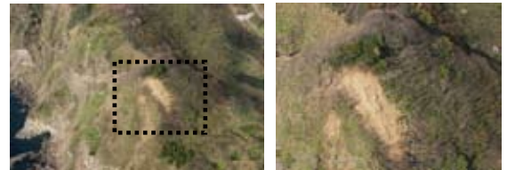
図－8 海岸部斜面崩壊箇所の被害状況確認（右拡大図）
