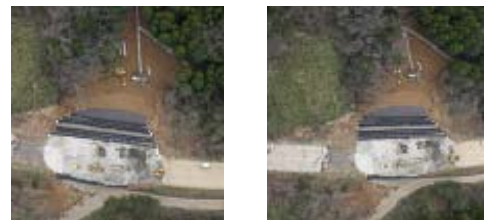
図－9 能登有料道路（崩壊部）の垂直連続撮影
