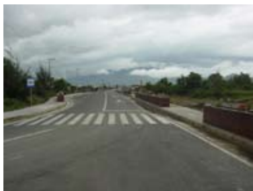
写真-6 道路修復
