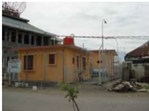
写真-7 排水ポンプ場
