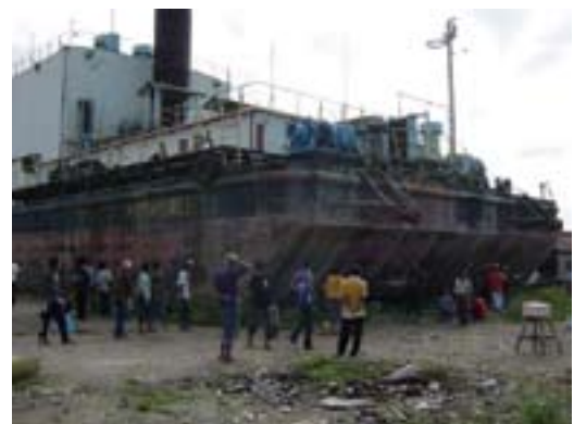
写真－４ 発電容量 1 万 kW の大型発電バージ船の遡上
