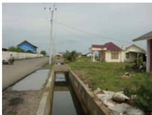
写真-8 排水路修復
