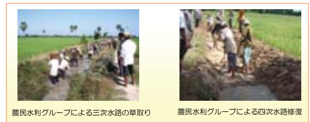
写真－5 灌漑施設の修復・維持管理活動
