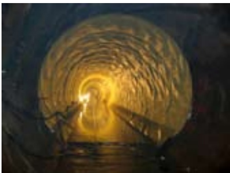
岩盤亀裂区間に適用された Geo-membrane
