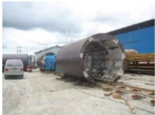
写真-7 テレスコピック型枠
