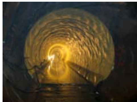
写真-6 岩盤亀裂区間に適用された Geo-membrane
