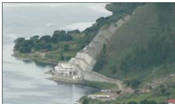
写真－2 発電所全景
