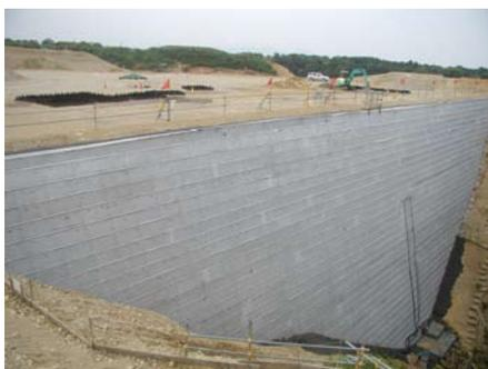
写真-7 補強土壁(2 の沢)全景
