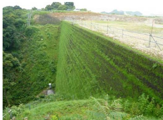
写真-9 壁面の厚層基材吹付け完了状況
