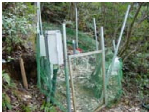
写真－3 計測器設置後の風景
