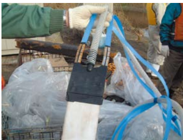
真空圧密ドレーン工法の概要
