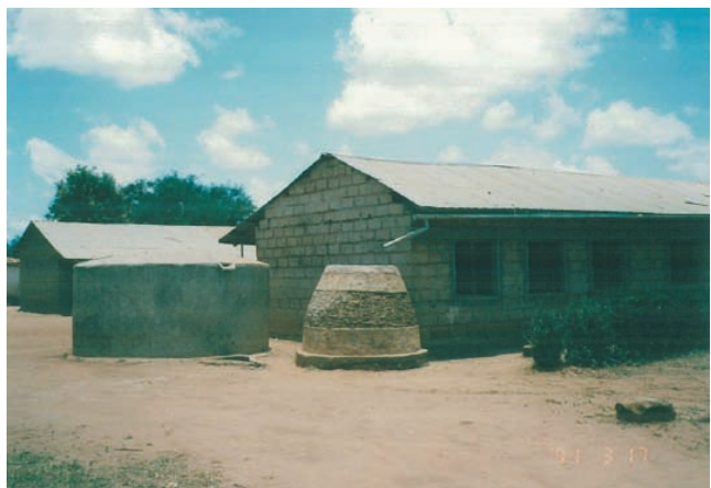
写真-2 屋根からの雨水を集水し溜めるためのタンク
