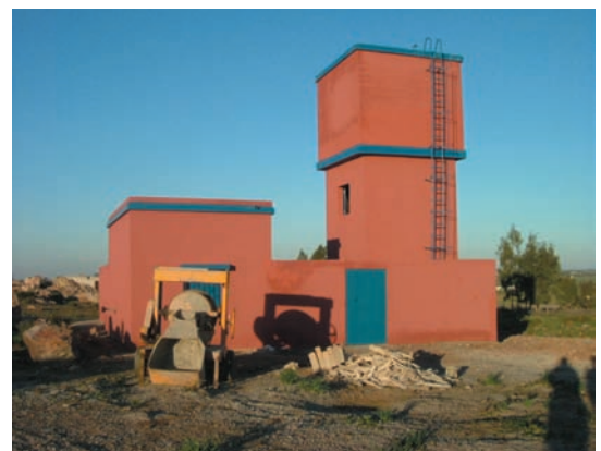
写真-7 「ベンスリマン地区飲料水供給計画」で日本・モロッコ両国協力の下設置された近代的給水施設
