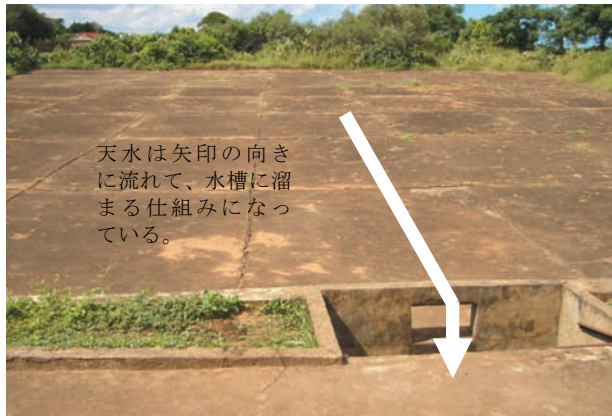
写真-8 マダガスカル国南部地域で長らく使用されてきた典型的な天水溜め施設
