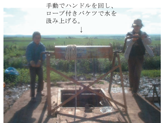
写真-6 ベンスリマン地区の伝統的浅井戸
