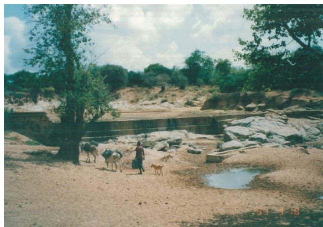
写真-4 砂の隙間に蓄えられる水を利用する砂ダム
