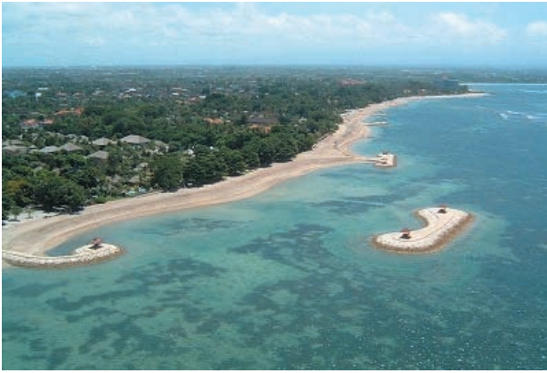
写真-3 地区 A 付近の空中写真
