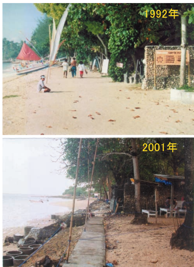
写真-1 Sanur 海岸における侵食状況
