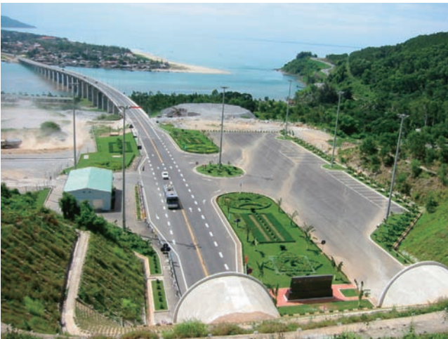
写真－1 ハイバントネルの北側坑口
