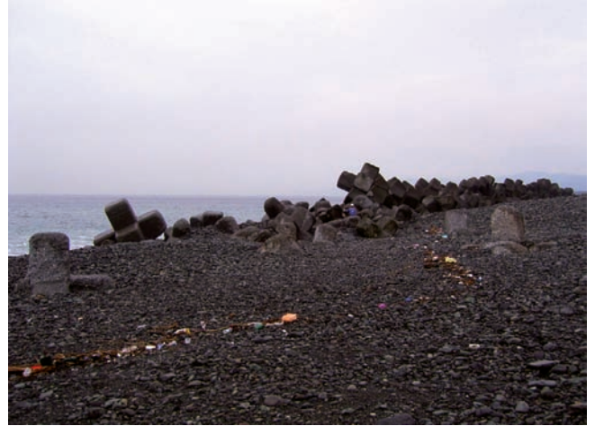
写真一1 富士海岸における台風来襲後のブロック散乱状況 (富士海岸吉原工区)
