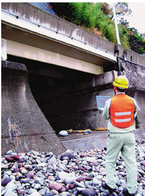
劣化診断ソフト使用状況
