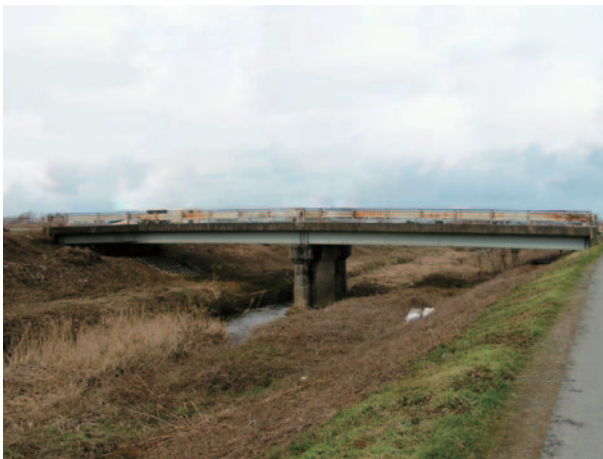
写真-4 橋梁全景
