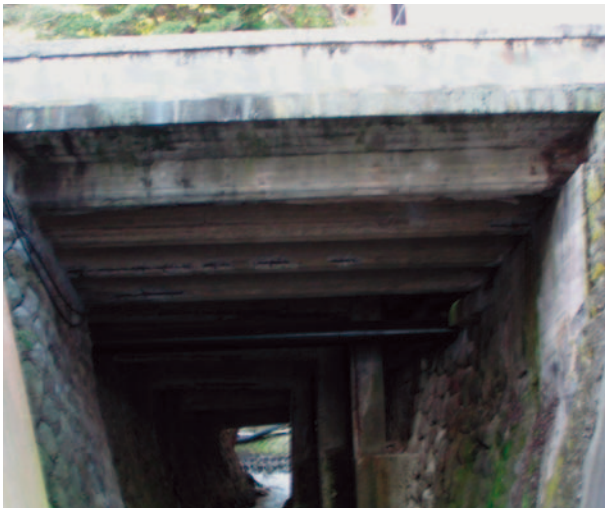
写真-2 橋梁全景
