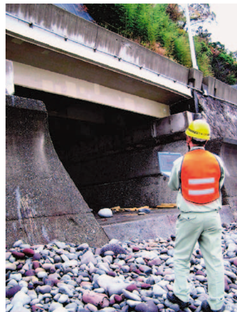
写真-1 劣化診断ソフト使用状況
