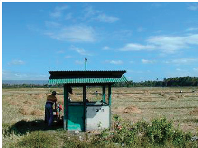
写真一1 オエサオ地区地下水灌漑施設
