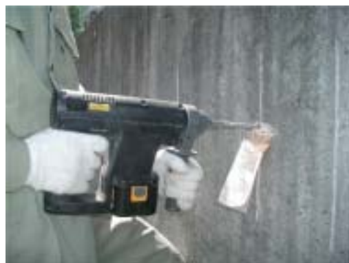
ドリル削孔状況
