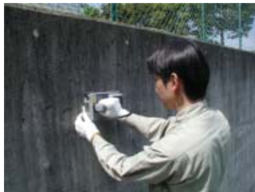
配筋調査状況(レーダ法)
