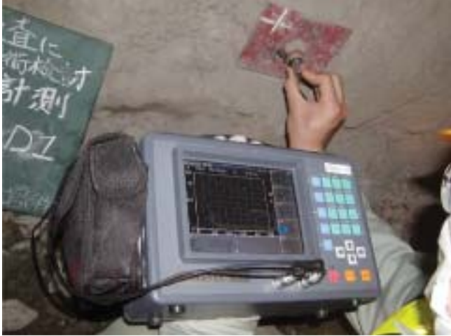
写真-2 専用器性能確認試験実施状況
