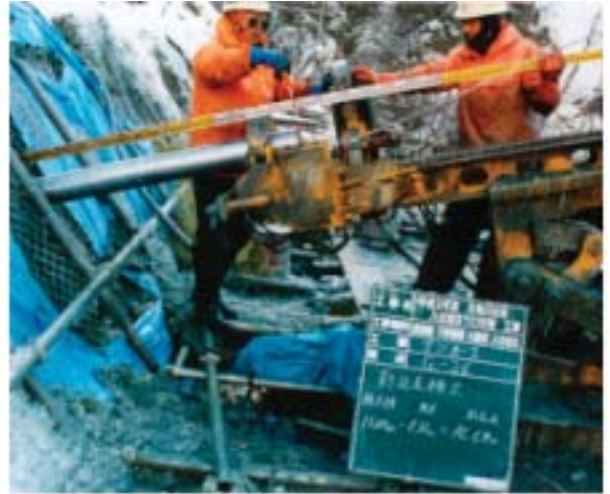
写真-3 グラウンドアンカー施工管理の現状
