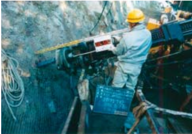
写真-5 削孔長管理装置の使用状況
