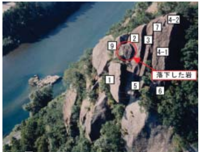
写真-3 全景写真(斜め後方より)
