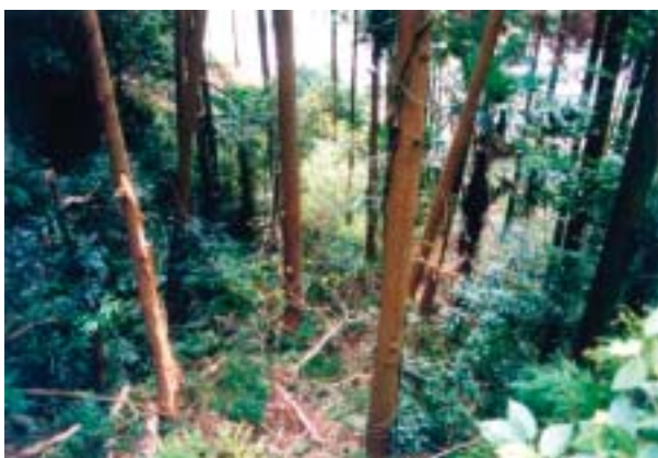
写真一5 落石の痕跡
