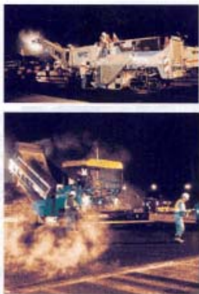
写真-1 施工状況(切削状況と舗設状況)
